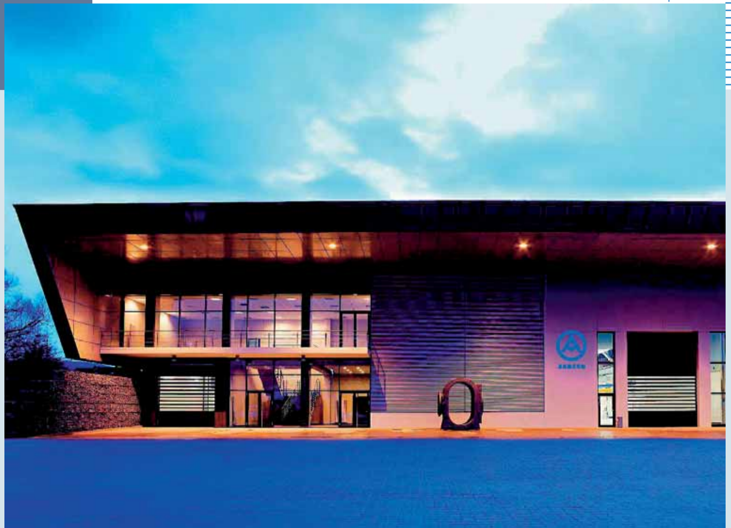
Modernste Architektur für modernste Technik – das neue Produktionscenter in Aerzen.
